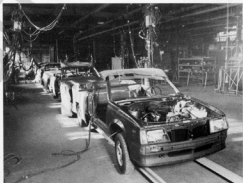
Die Fahrzeuge werden während der gesamten Verstärkungsmaßnahmen auf Schienen hydraulisch entlang bewegt.
